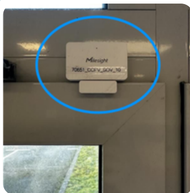
Contrôle de la fermeture des ouvrants
