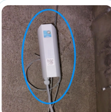
Contrôle du fonctionnement d'une VMC, d'une CTA
