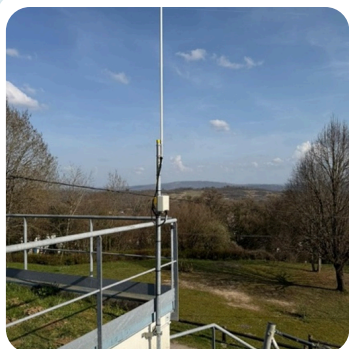
Pirey - réservoir d'eau
